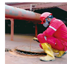
作業前のタンク内 ガス検知作業
