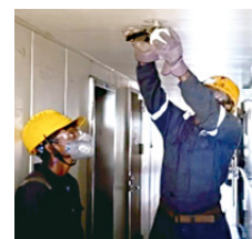
解体前の船内有害物質 除去作業
