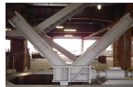
建設中の新ダイビルにおける制振装置
