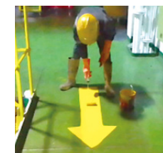
船内避難経路更新・ 再塗装作業
